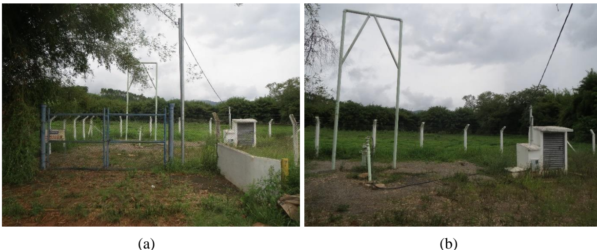
Figura 5.4: (a) Entrada do poço de captação no bairro Anhumas; (b) Estrutura de captação.
