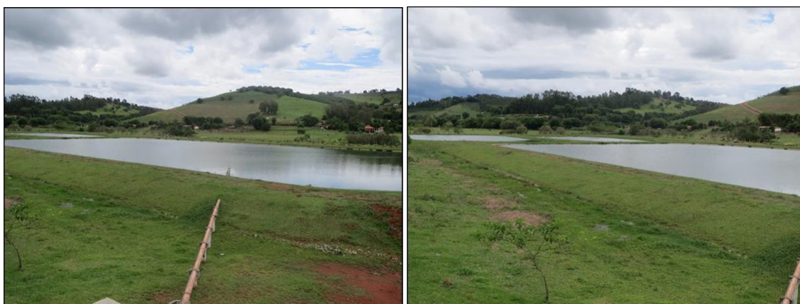
Figura 5.19. ETE Pedralva - Lagoa facultativa e lagoas de maturação.
