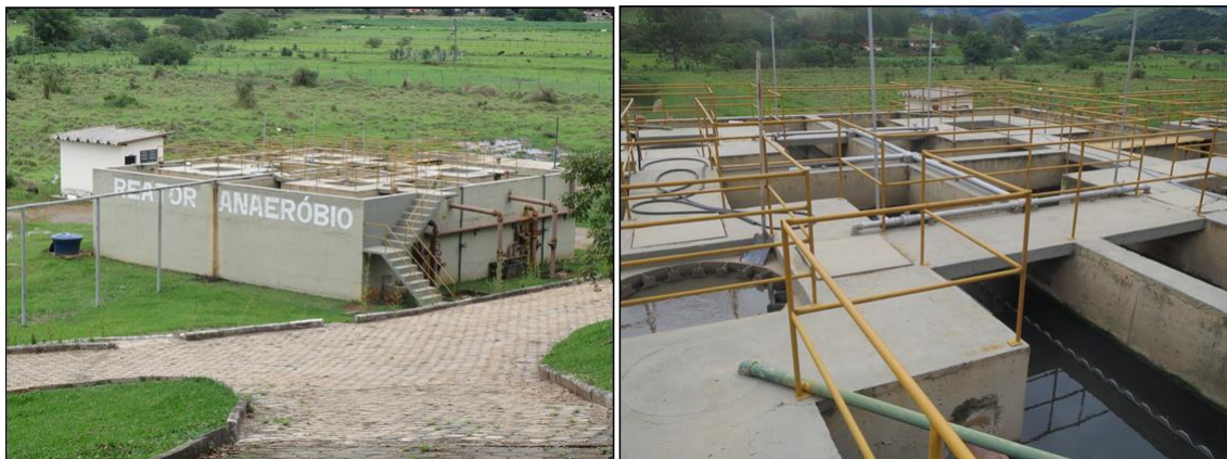
Figura 5.17. ETE Pedralva - Reator anaeróbio.
