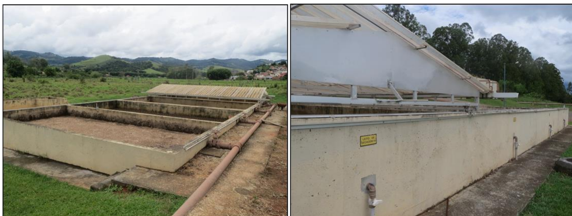
Figura 5.18. ETE Pedralva - Leito de secagem do lodo resultante do Reator anaeróbio.
