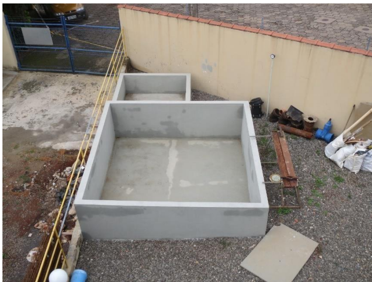
Figura 5.10: Tanque sendo construído para armazenar o sulfato de alumínio.
